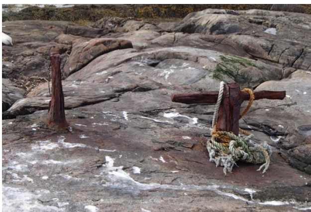
Foto 12 Reg: Nr 222 og 223 Ringskjær Kalvøund. Sterkt forrustet fortøyningsbolter av store typer. Begge boltene er festet med bly. Det er antatt at bly var vanlig festemiddel før år 1800.
