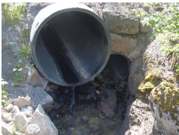
Bilde: Rør under vei ca 130 meter oppstrøms bekken
