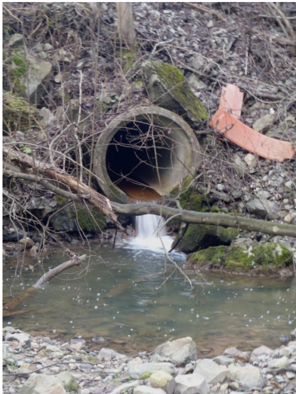
Bilde: Oppgangshindre, rør med innhopp
