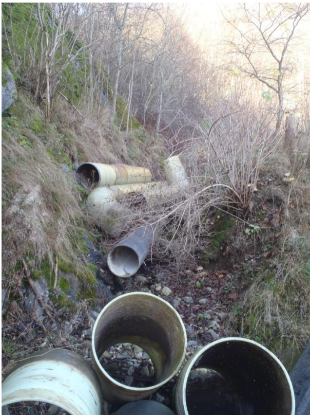
Bilde: Her har trolig det gamle bekkeløpet gått, bilde er tatt på oversiden av riksveg 353
