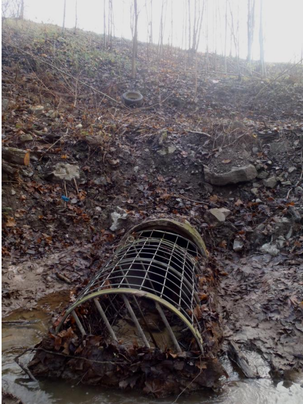
Bilde: Utløp av rør med tilhørende inntaksgitter som danner oppgangshindrende høydesprang.
