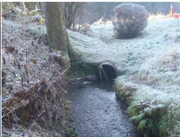
Bilde: Rør under jorde sett fra oppstrøms side
