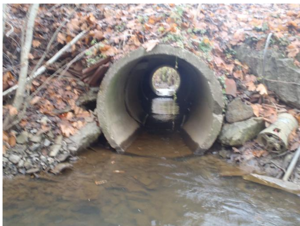
Bilde: Kryssing under Nystrandveien sett fra oppstrøm side
