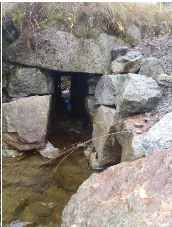
Bilde: Steinsatt kulvert under bilvei, uproblematisk
