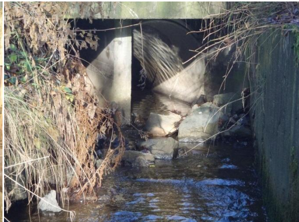
Bilde: Kryssning av veier sett fra nedstrøm side
