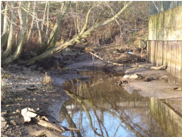
Bilde: Sett fra utos og oppstrøms
