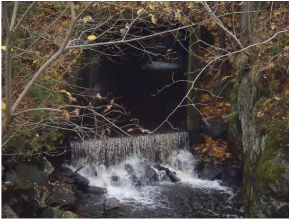
Bilde: Oppgangshinder 1, betongkulvert
