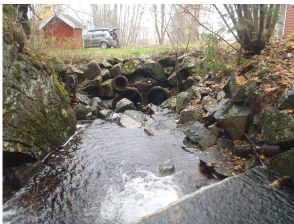
Bilde: Bekken sett fra oppgangshinder og nedstrøms
