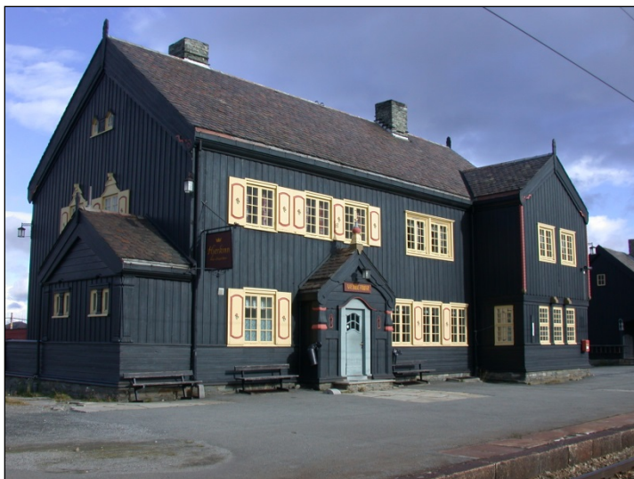
Figur 3 Hjerkind stasjon langs Dovrebanen
