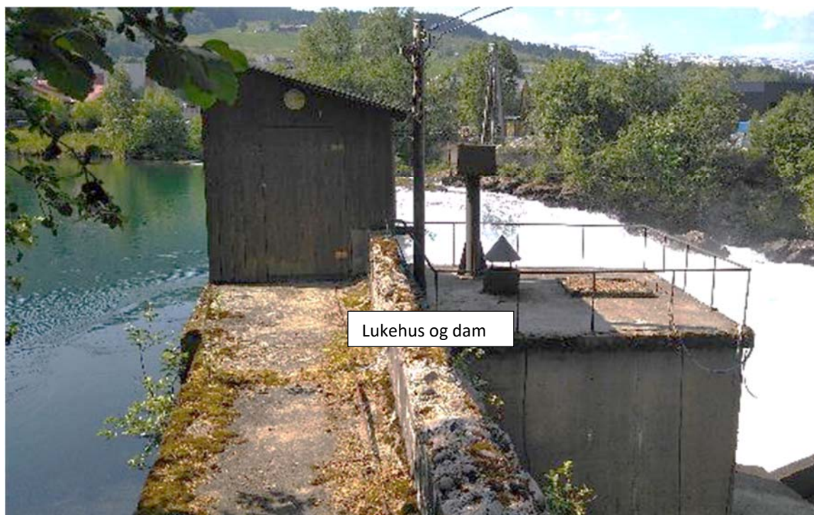
Figur 4: Foto av rørgate, dam og lukehus
