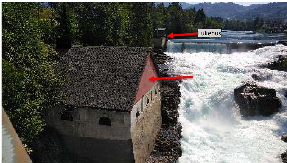
Figur 7: Bildet viser rødmalte, asbestholdige fasadeplater på gavlvegg på kraftstasjonen, samt lokalisering av en asbestholdig bygningsplate på lukehuset
