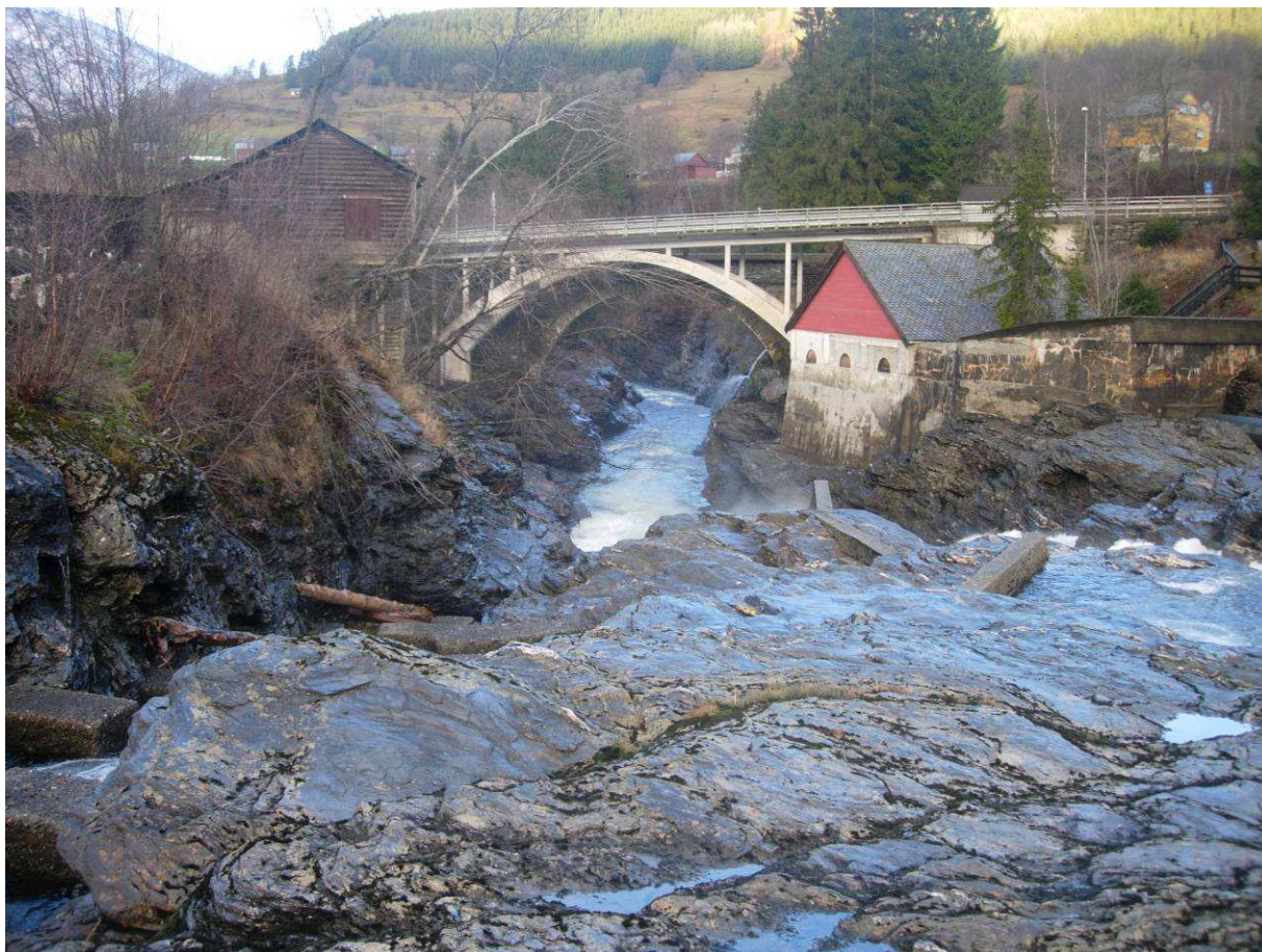
Figur 7. Palmafossen kraftverk. Bilde er tatt mot nordvest.
