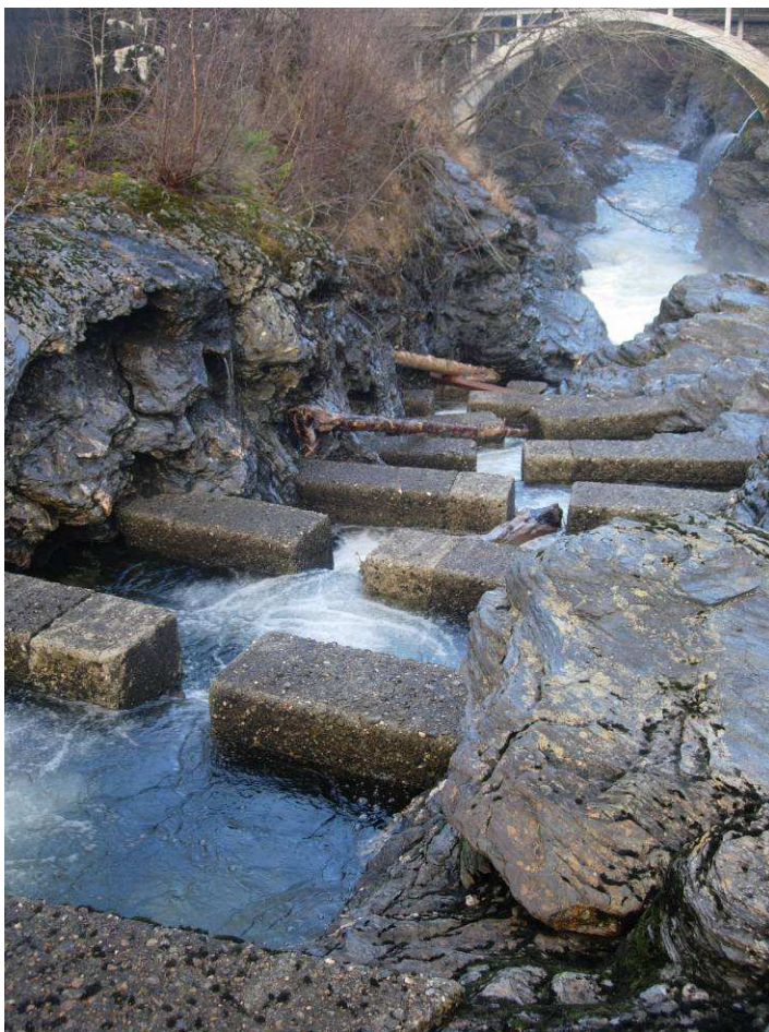
Figur 16. Laksetrappa i Palmafossen, sett ovenfra mot vest.
