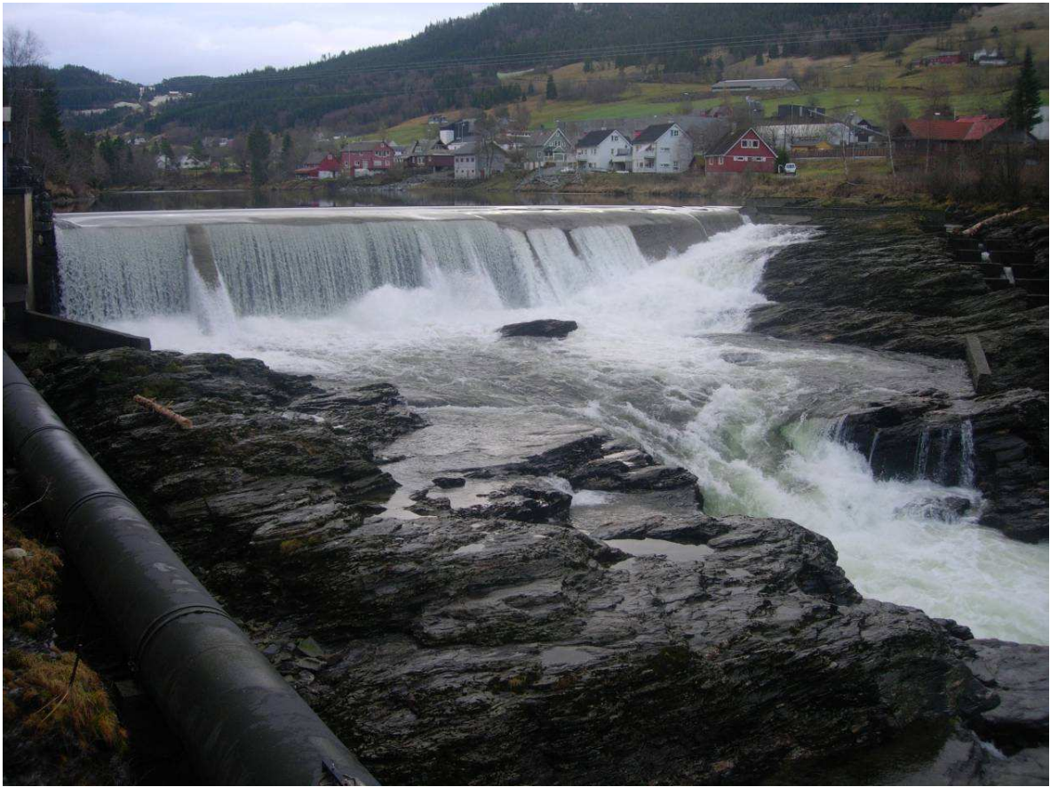
Figur 11. Dammen i Palmafossen, sett mot sørøst.
