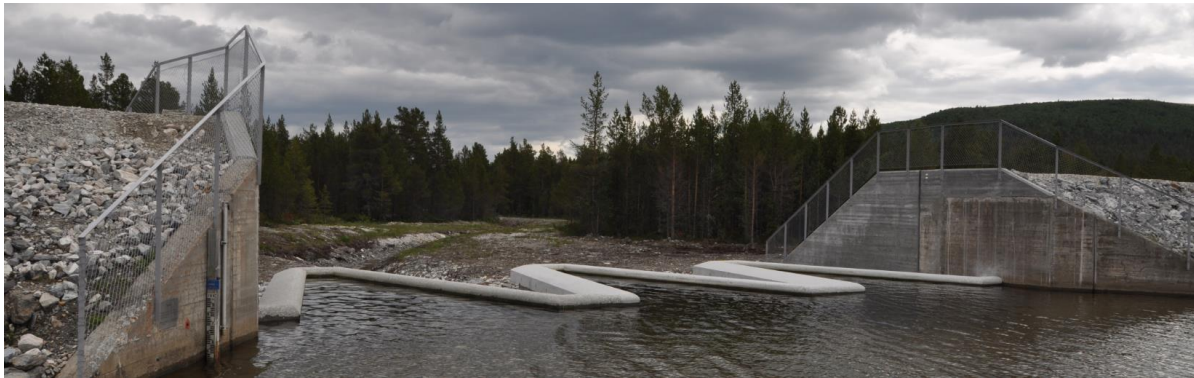
Figur 13 viser et mindre labyrintoverløp ved Savalen sett fra oppstrøms side, der konstruksjonen gjør seg mindre gjeldende, men likevel blir et blikkfang.
