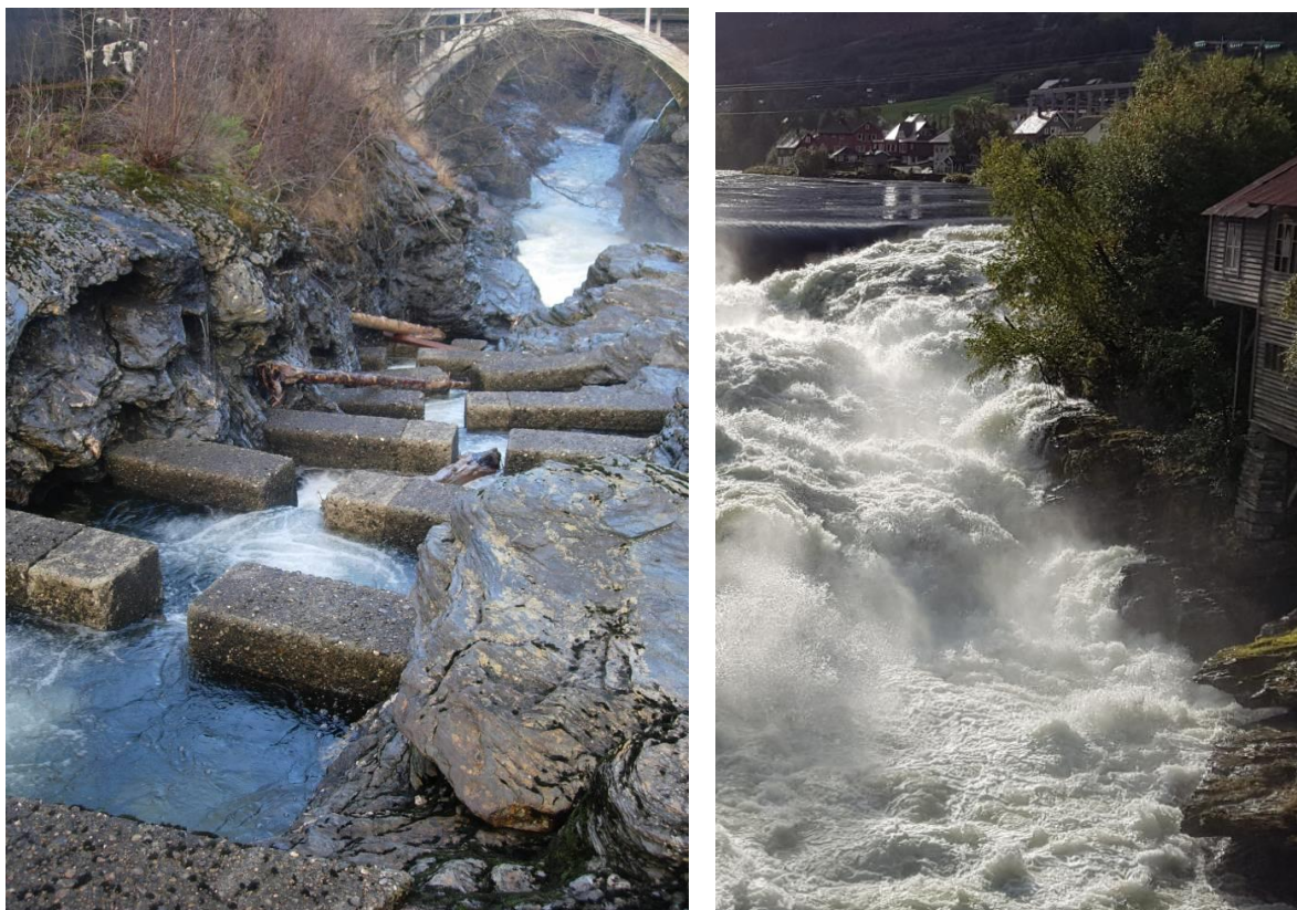
Figur 2-3 Laksetrappa i Palmafossen, sett ovenfra mot vest ved lavføring og nedenfra mot øst ved høy vannføring. Bildet til venstre er fra Fjeldstad og Gaarder 2008.
