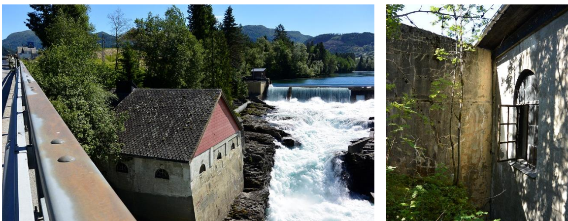
Figur 4 Oppføring av brua langs fv.307, Tjukkbygdvegen, like nedstrøms kraftstasjonen har stor innvirkning på opplevelsen av bygget sett nedstrøms. Det rødmalte panelet på gavlveggen ut mot elva drar oppmerksomheten mot en fasade uten spesiell verdi både historisk og estetisk. Bildet til høyre viser at fine detaljer i fasaden mot øst er skjult bak flomveggene.
