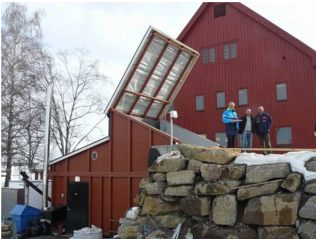
Nytt bioenergianlegg på Blæstad april 2009
