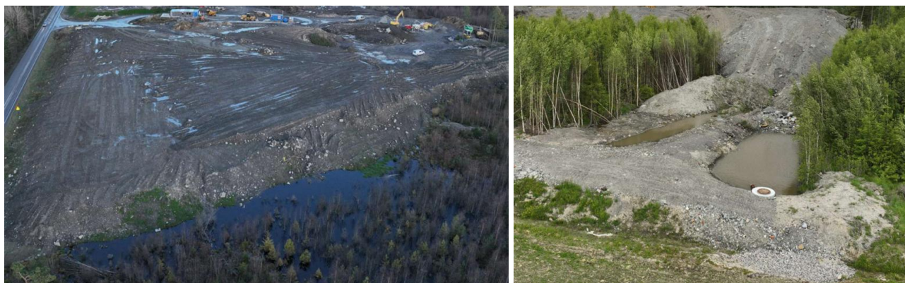
Figur 4-3: Dagens situasjon som viser «vestre fangdam» (t.v.) og «østre fangdam» (t.h.) [9].
