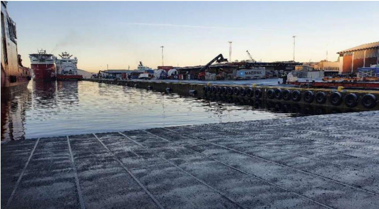
Figur 3-2 Bilde tatt fra dagens ro-ro-rampe viser pelekaier innerst i Jekteviken, ut mot Jekteviksutstikkeren [1].
