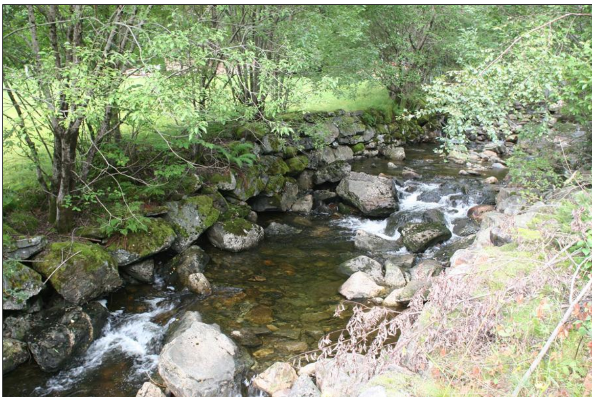
Fig. 50. Forbygd avsnitt av Aldalselva, mellom Rv7 og Haukanesvegen. 4. august 2011. Foto: A. Håland
