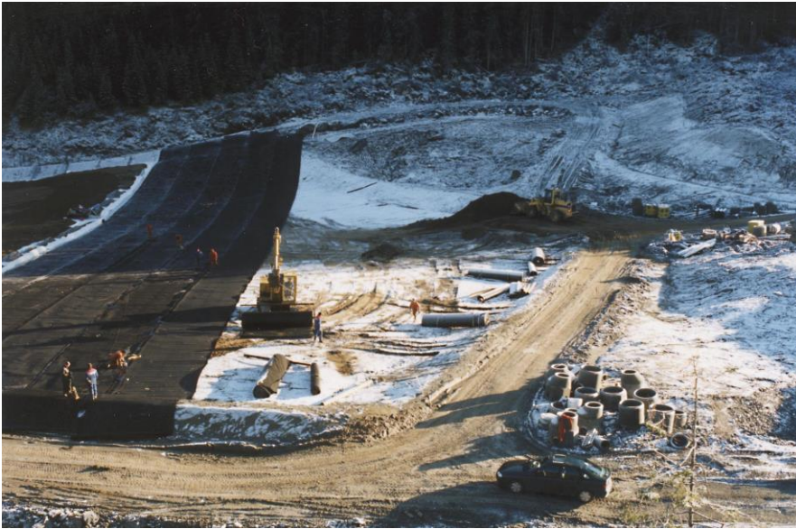
Figur 5: Legging av gummimembran på trinn 1 og 2 på deponiet
